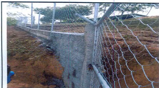
Foto 3: se observa la construcción del cerco en la parte del riesgo de una pendiente cerca del establecimiento.
