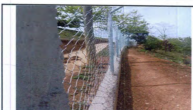
Foto 4: se observa la circulación del predio de la parte de enfrente del establecimiento.
