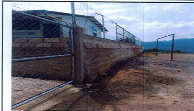
Foto 1: se observa la construcción del muro de soporte de la escuela, finalizado al 100%.
